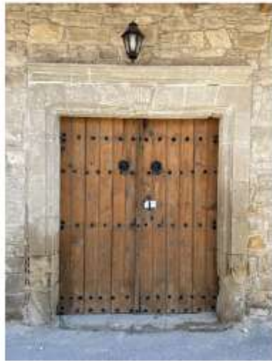
Αστικού τύπου ταμπλαδοτές με πελεκητό πλαίσιο
