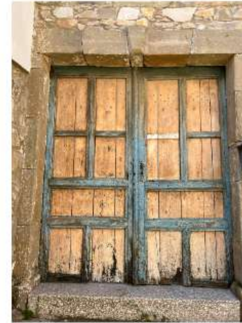
2. Νταμπλαφωτή δίφυλλη μακρόστενη εξώθυρα, με περιθυρώματα και πελεκητή πέτρα.
