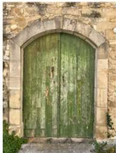
Πελεκητό πλαίσιο και χαμηλωμένο τόξο - Αγροτικές
