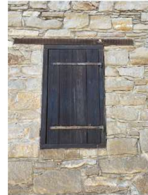
2. Μονόφυλλο σανιδωτό παράθυρο με οριζόντιο ανώφλι.
