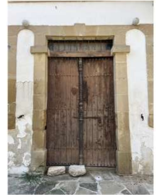
3. Σανιδωτή δίφυλλη μακρόστενη εξώθυρα, με περιθυρώματα και πελεκητή πέτρα και σιδεριές φεγγίτη στο πάνω μέρος.
