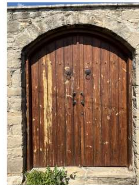
5. Σανιδωτή δίφυλλη τοξωτή εξώθυρα, με περιθυρώματα και κατεργασμένη πέτρα.
