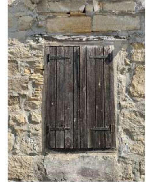
3. Απλό σανιδωτό δίφυλλο παράθυρο με οριζόντιο ανώφλι.
