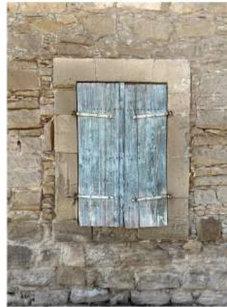
1. Σανιδωτό δίφυλλο παράθυρο με πελεκητό πλαίσιο.
