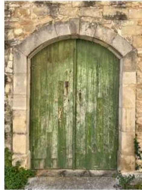
1. Σανιδωτή δίφυλλη τοξωτή εξώθυρα, με περιθυρώματα και πελεκητή πέτρα.
