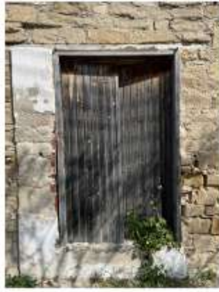
Αστικού τύπου ταμπλαδοτές με πελεκητό πλαίσιο
